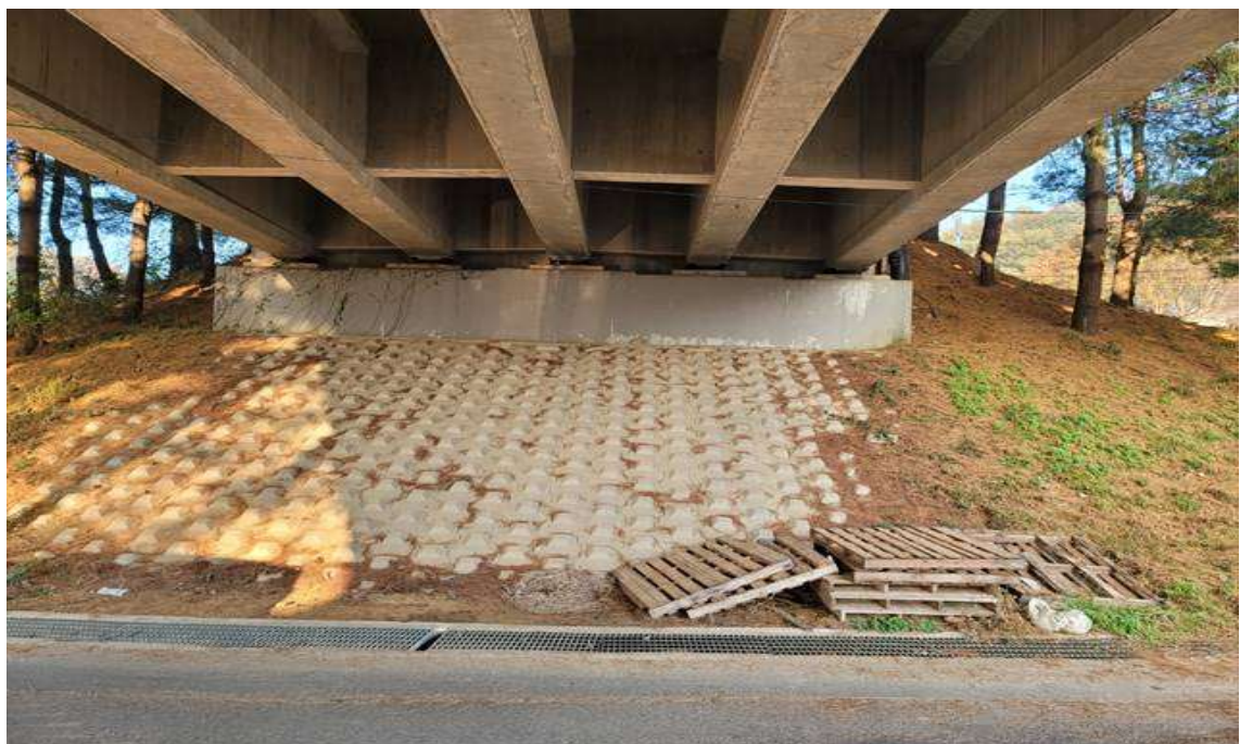
교대 A2 전경
