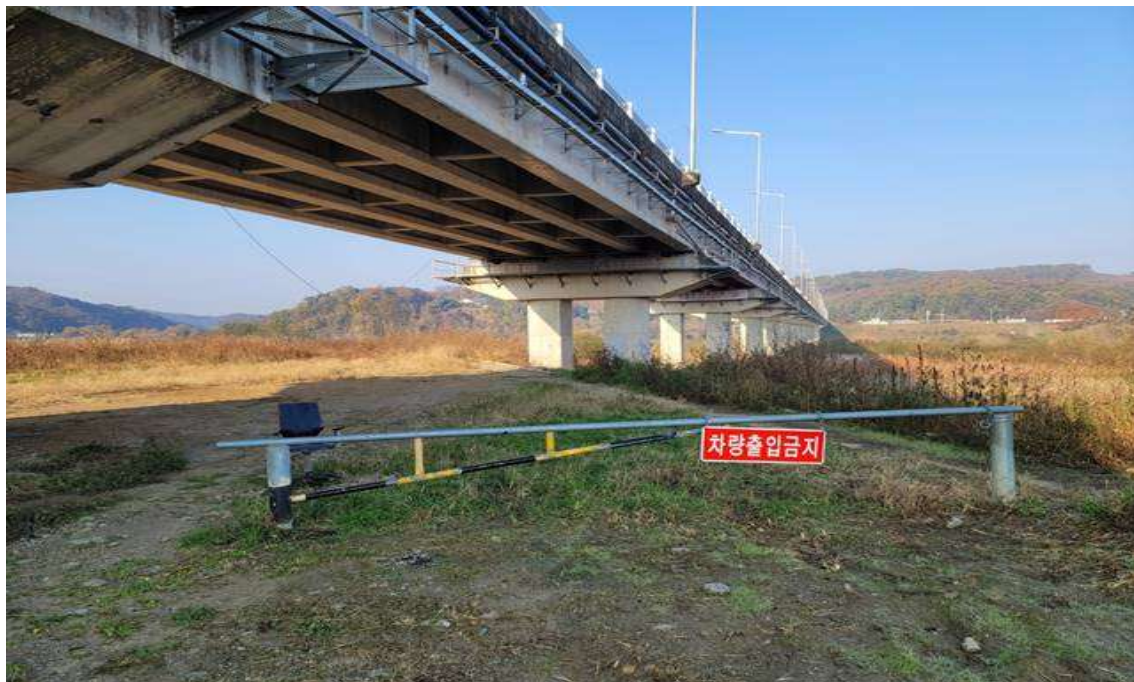
교각 P2~P10 전경
