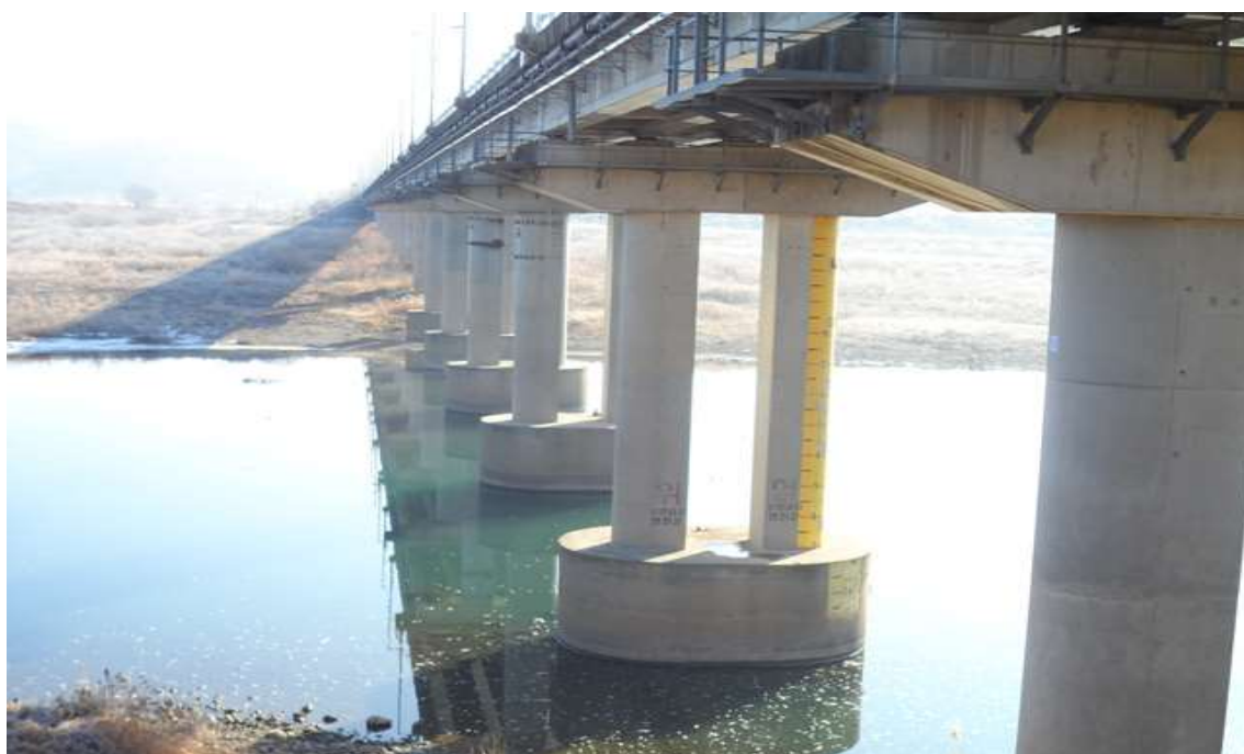
교각 P11~P16 전경
