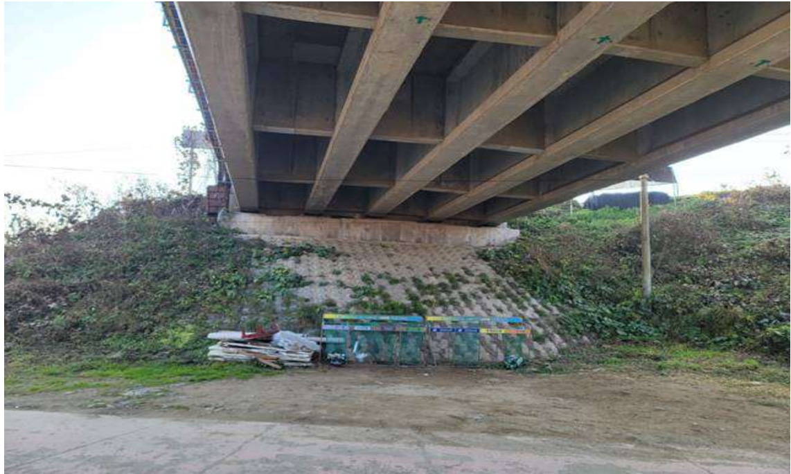
교대 A1 전경
